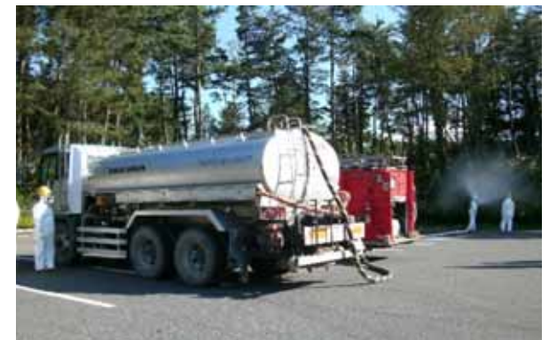
散水実施状況
