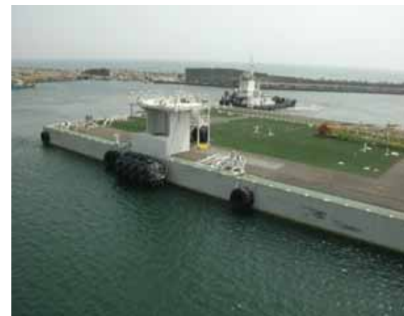
低濃度滞留水用タンク （メガフロート）
