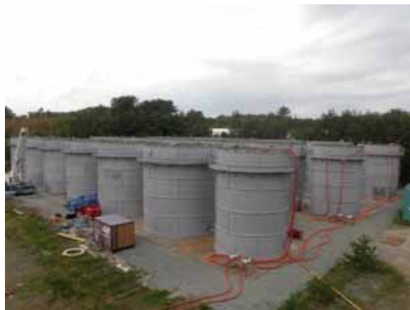
低濃度滞留水用タンク
