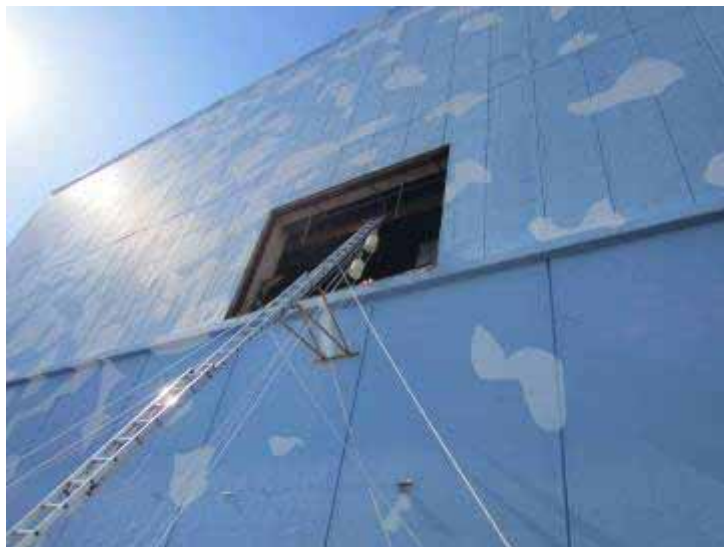
ブローアウトパネルでの測定の様子
