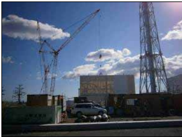
原子炉建屋上部の測定の様子
