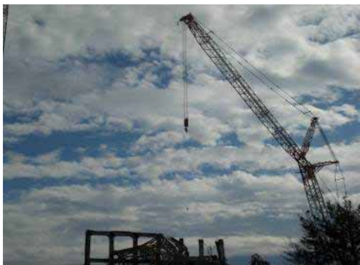
原子炉建屋上部の測定の様子
