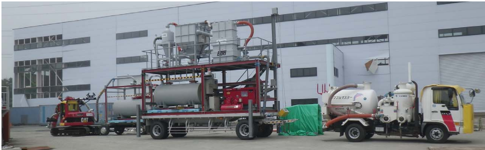
<集塵機システム全景>
