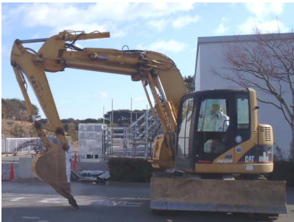
路面のケレン状況
