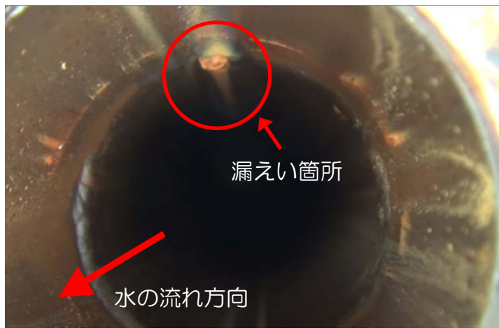
弁取外し後（上部より）
