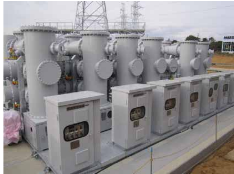
66 kV 開閉設備 (GIS)
