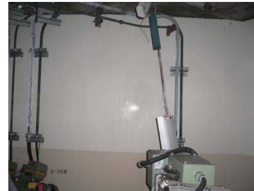
使用済燃料プールを支持する壁
