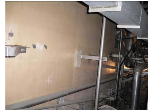
使用済燃料プールを支持する壁
