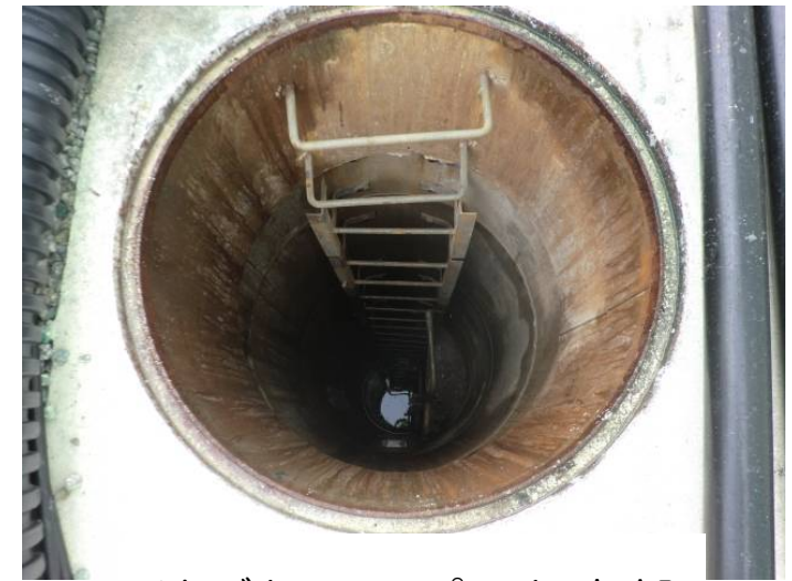
サブドレンピット内部
