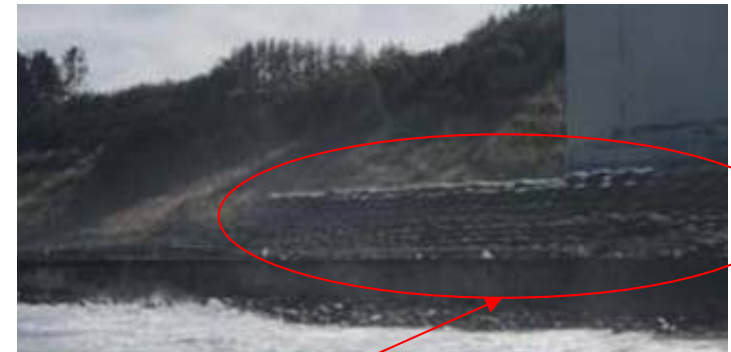
仮設防潮堤設置状況
