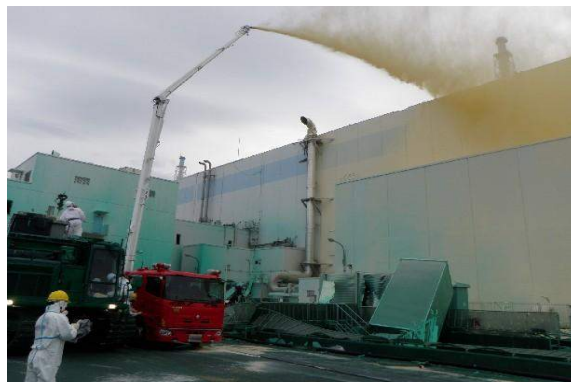
敷地、建屋本体への飛散防止剤散布
