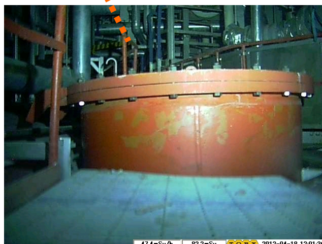
2号機トラス室内調査 (4/18/2012)
