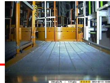
南東マンホール
