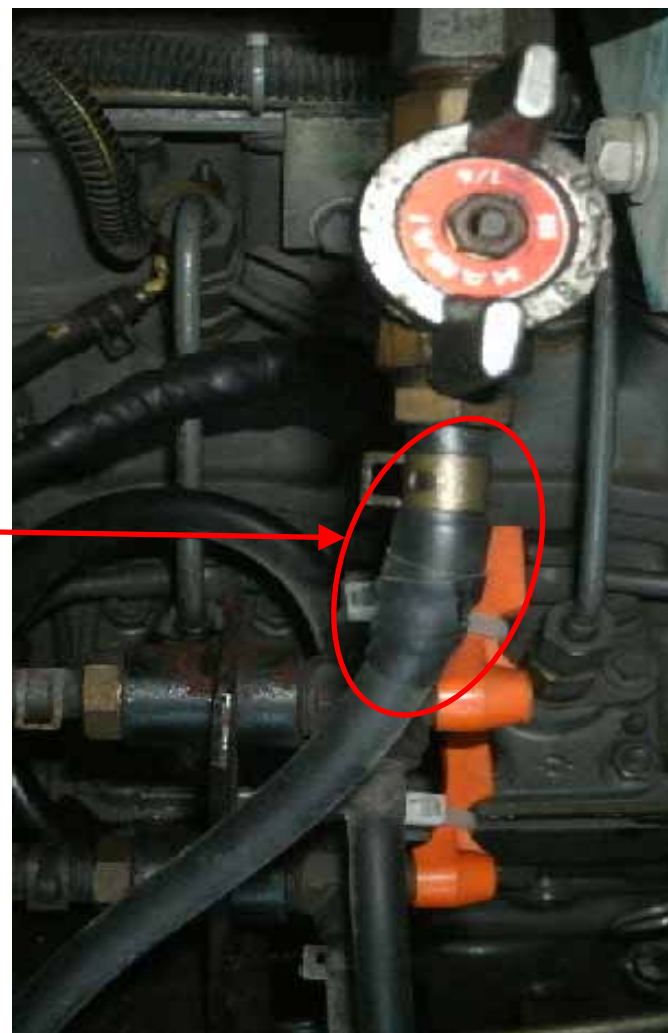
応急処置後 (テープで補強し、油漏れは停止)
