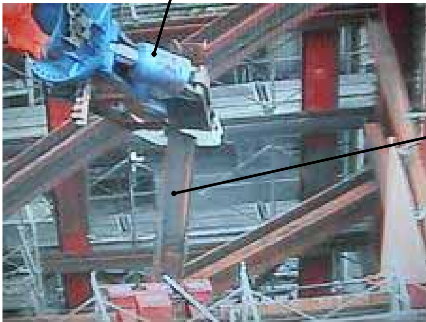
モックアップ試験 （吊上げ時）
