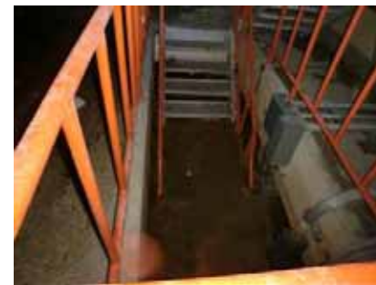
3号機階段室(北西)
