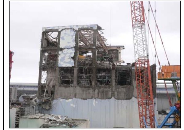
写真 撮影No 位置 RG-R2~R6間 72 - コメント 被りコンクリート剥落
