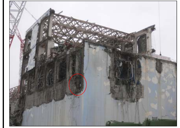
写真 撮影No 位置 RG-R6~R7間 71 - コメント 崩落
