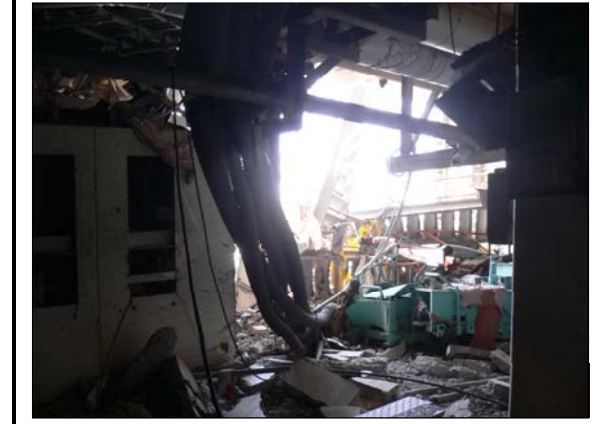
写真 撮影No 位置 RG-R1~R2間 73 087 コメント 崩落
