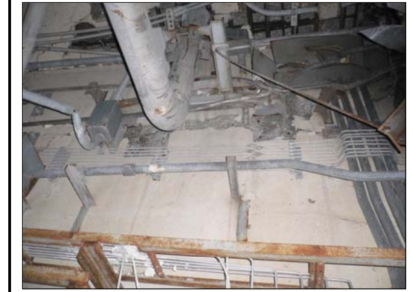
写真 撮影No 位置 R7-RE~RF間 69 089 コメント 全体的に変形
