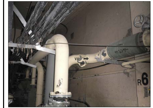
写真 撮影No 位置 RBa-R2~R6間 65 075 コメント 異常なし
