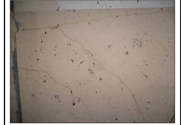
写真 撮影No 位置 R3-RE~RF間 78 082 コメント 異常なし (0.2mm程度のひび割れ)
