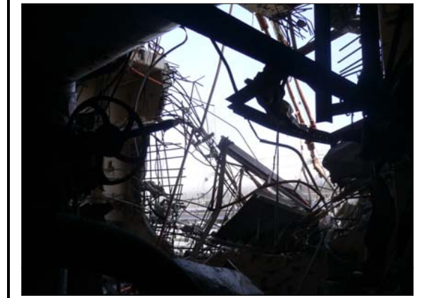
写真 撮影No 位置 RBa-R1~R2間 64 077 コメント 崩落
