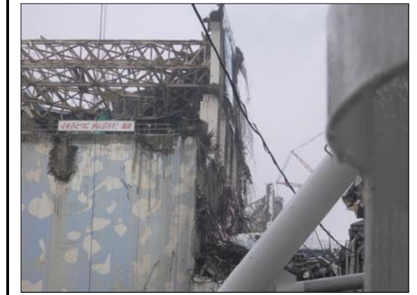
写真 撮影No 位置 東側、南側外壁 63 238 コメント 東側外壁一部崩落、南側外壁一部被りコンクリート剥落
