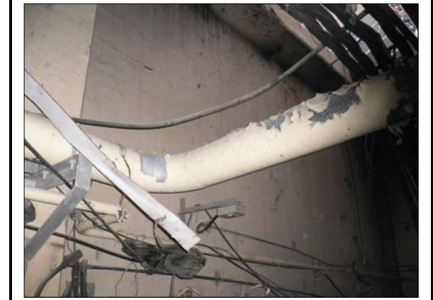
写真 撮影No 位置 RBa-R6~R7間 66 074 コメント 異常なし
