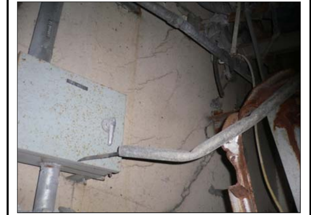
写真 撮影No 位置 R7-RE~RF間 70 090 コメント 全体的に変形
