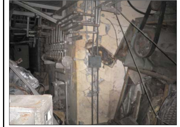
写真 撮影No 位置 RD-R1~R2 76 079 コメント 全体的に変形
