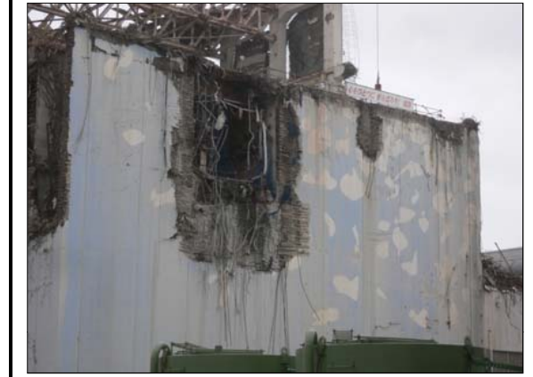
写真 撮影No 位置 R7-RC~RF間 68 - コメント 外部被りコンクリート剥落
