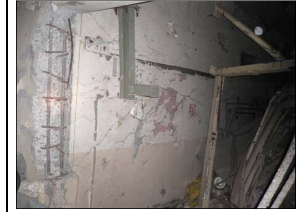
写真 撮影No 位置 R1~R2-RD~RE間 77 080 コメント 全体的に変形
