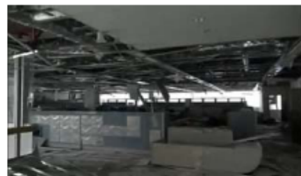
事務本館の状況（平成23年3月6日撮影）
