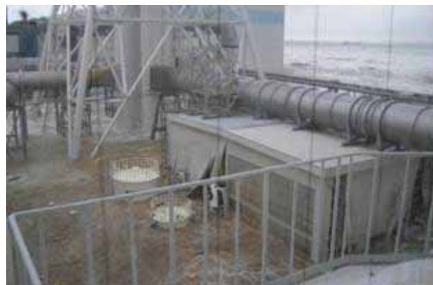
写真3. 福島第一原子力発電所 津波来襲状況 集中廃棄物処理建屋4階から北側を撮影 （平成23年3月11日撮影）
