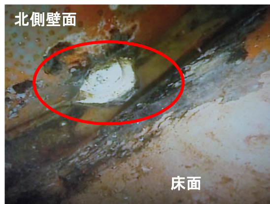
【Ⅲ部】（矢視D）突起物と約5 cmの割れ
