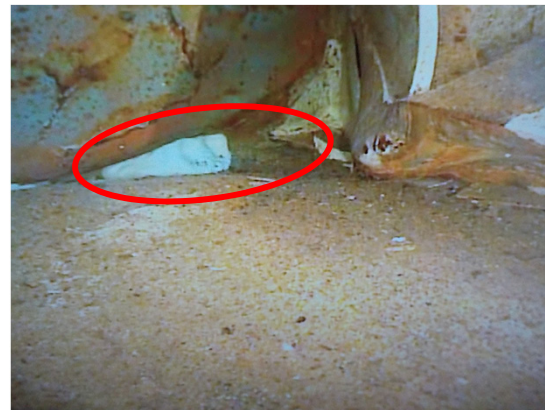
【Ⅰ部】内面・外面肉盛り溶接＋パテ補修
