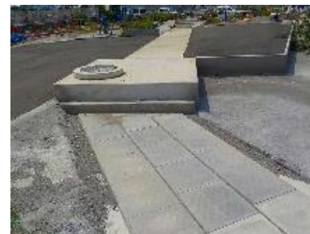
④トラフ設置(2013年以降の新設電路)
