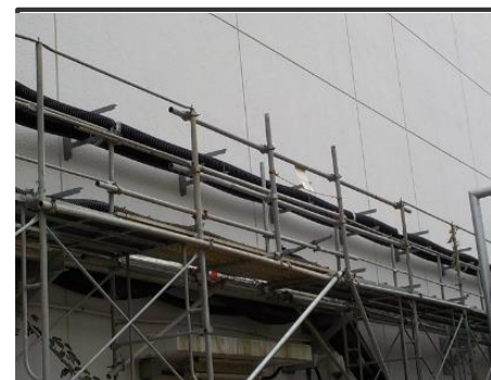
④トラフ設置(2013年以降の新設電路)
