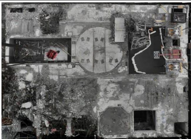
大型ガレキ撤去完了後のオペフロ（撮影日2014年1月31日）
