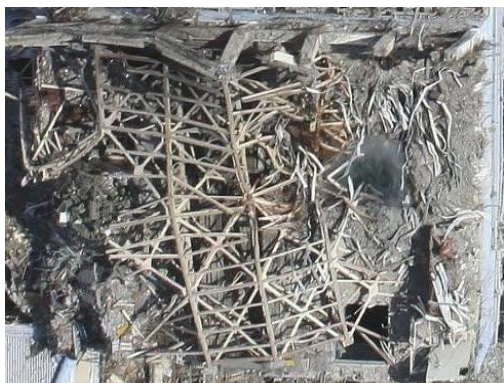
大型ガレキ撤去着手前のオペフロ（撮影日2011年3月24日）
