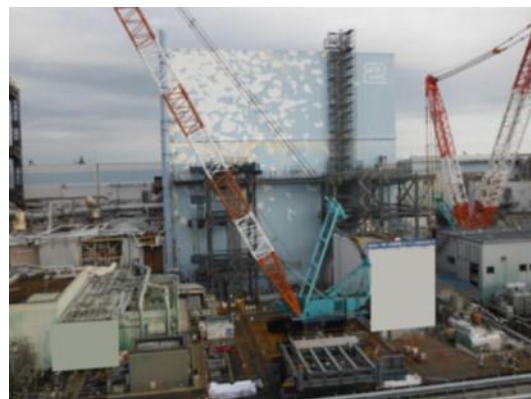
2号機原子炉建屋 西側構台建方状況
