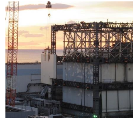
建屋カバー壁パネル 取り外し作業の状況 (2016年11月10日撮影)
