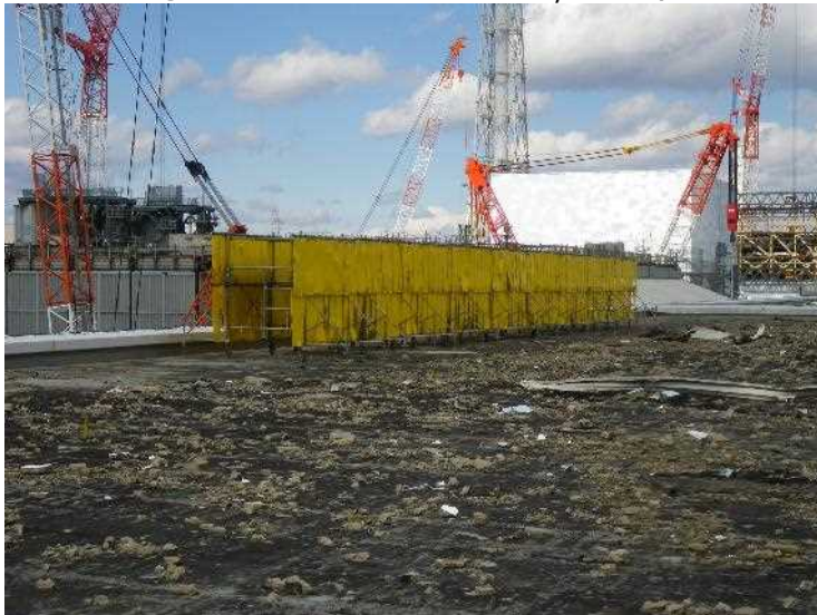
【写真③】 遮蔽壁設置中（4号機T/B屋根）
