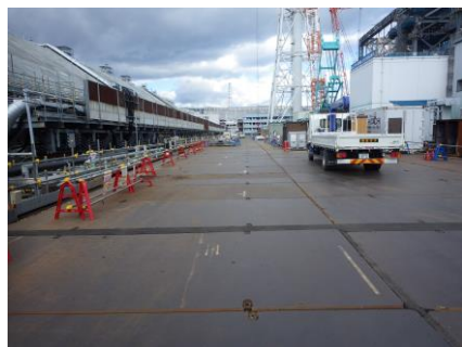
写真① 西側路盤整備完了
