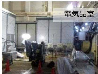
① 2階設置箇所 (電源関係)
