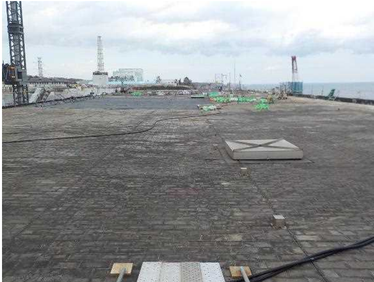
【写真③】 遮蔽壁設置中（4号機T/B屋根）
