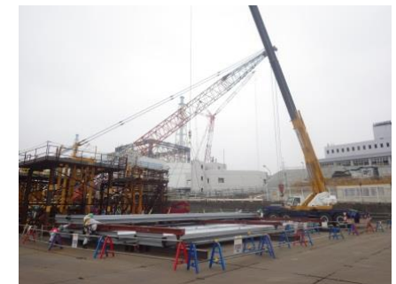
写真⑤ 地上での地組状況
