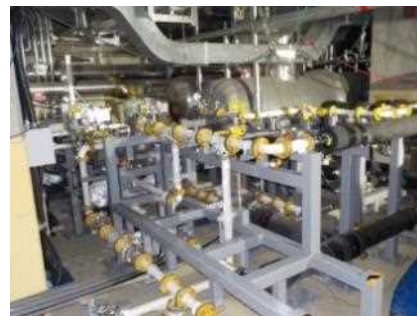
② 地下1階設置箇所 (弁ユニット)
