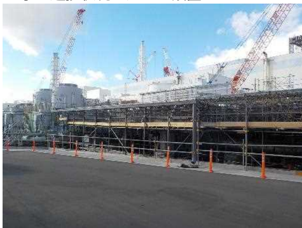
サブドレン移送ポンプ建屋周辺
