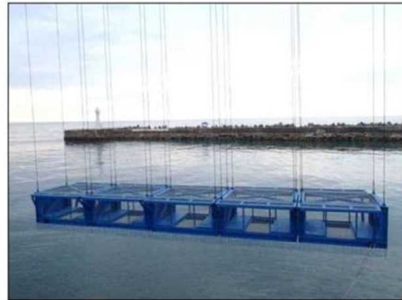
ブロックフェンス設置時の様子
