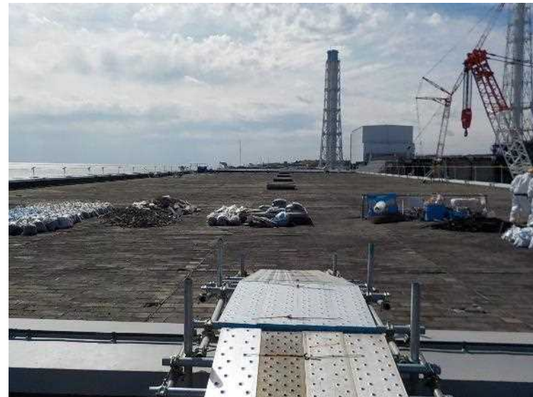
【写真②】 ガレキ撤去中（2号機T/B屋根）
