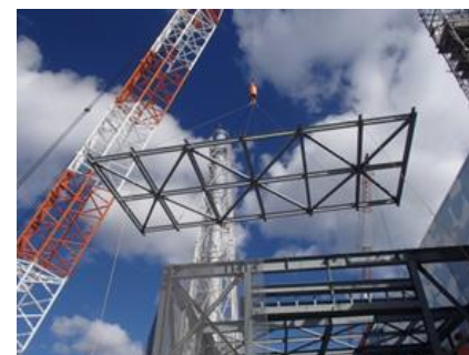
写真④ 前室鉄骨設置状況
