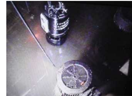
④ 地下1階 床ドレンサンプへの ポンプ設置状況
