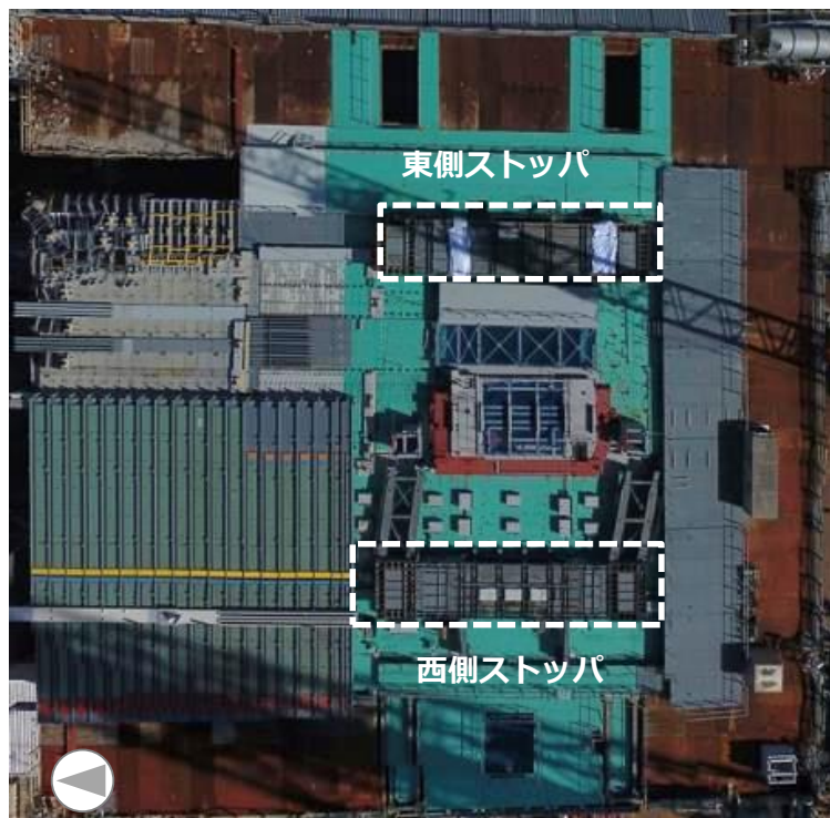
ストッパ設置状況（撮影日2017年2月13日）
