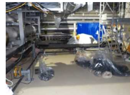
③ 地下1階設置箇所 (移送配管)
