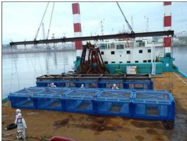
ブロックフェンス設置時の様子
