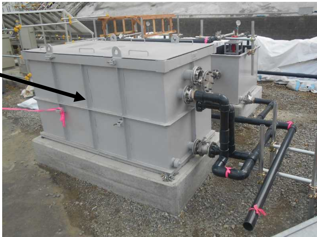
【K排水路モニタ改造状況】
