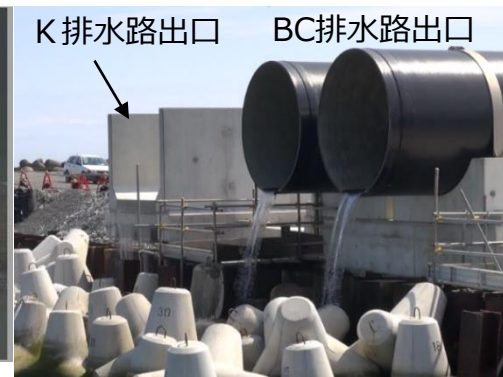
付替後排水路出口
