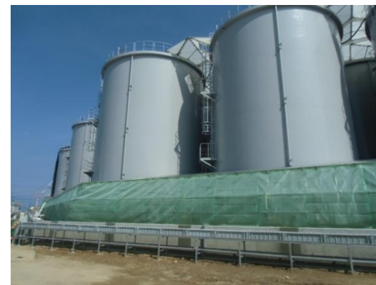
タンク堰カバー・雨樋
