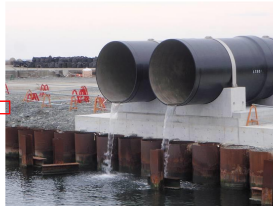
付替後排水路出口
