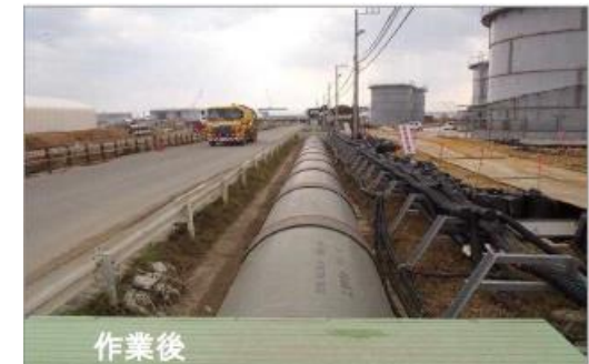
作業後 B排水路暗渠化
