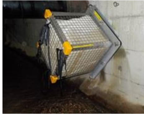
枝管への浄化材設置状況
