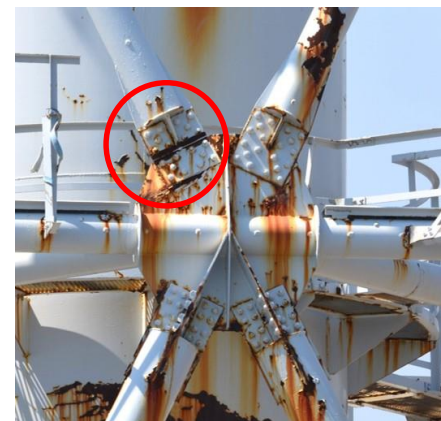
破断箇所（例）
