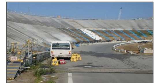
モルタル吹付け施工状況
