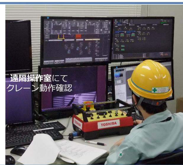
燃料取扱機・クレーンの動作確認状況
