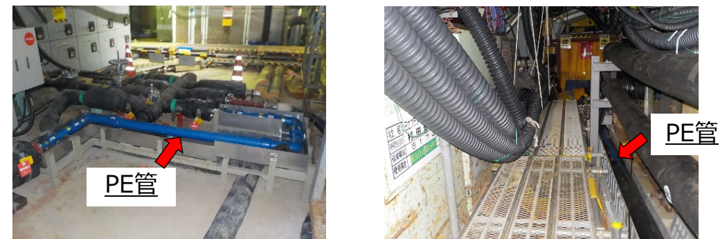
新規PE管施工後
