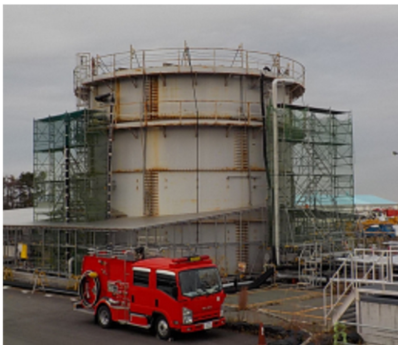
処理水バッファタンク外観
