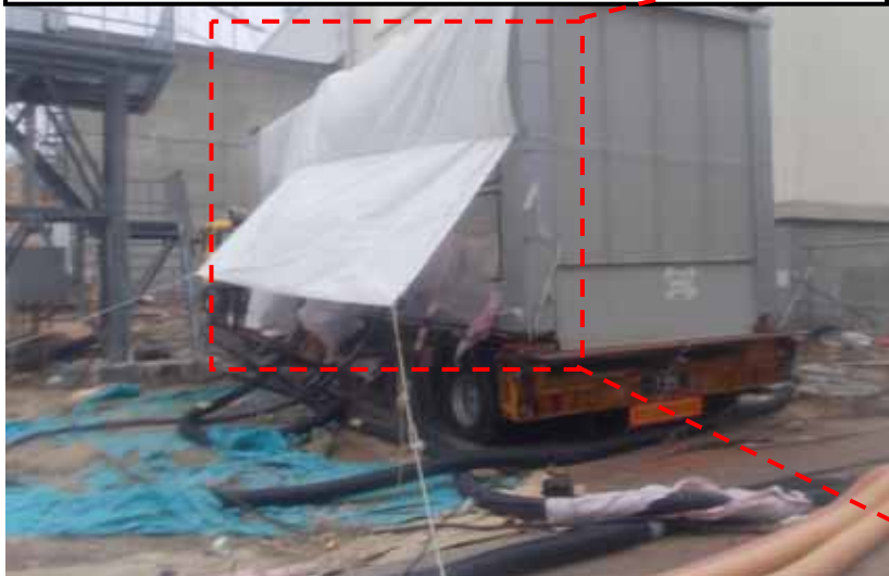
仮設3 / 4号M / C ( A ) 設置コンテナ
