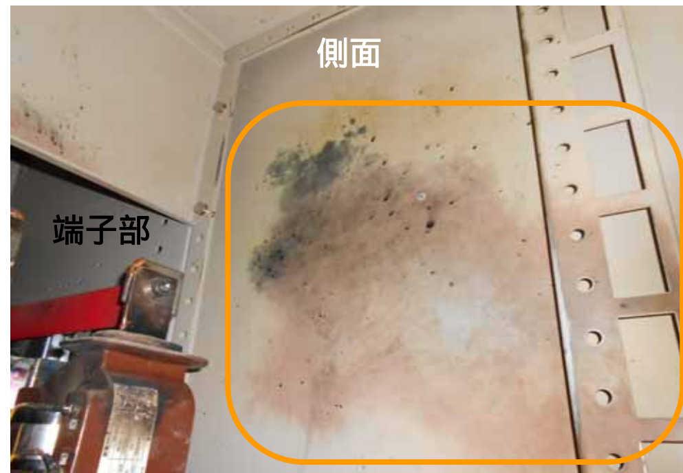
5 Aユニット側面のアーケ痕状況
