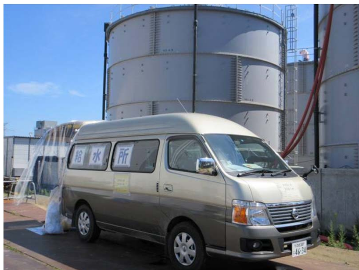
移動式給水所（多核種除去設備前）
