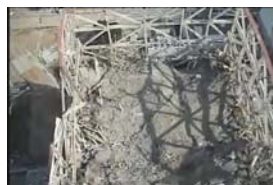
1号機(カバ設置前)
