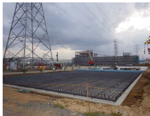
<凍結プラント基礎の構築状況>
