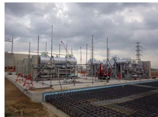
<凍結プラント 冷凍機設置状況>
