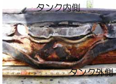
解体状況（底板B側）
