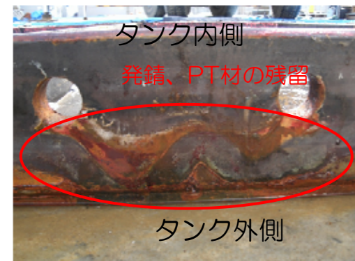
解体状況（底板A側）
