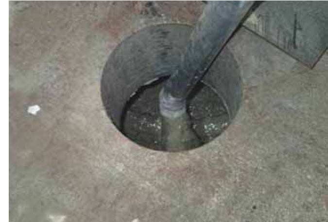
グラウト充填 施工状況
