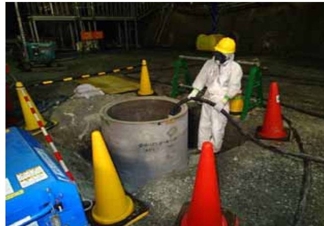
グラウト充填 施工状況
