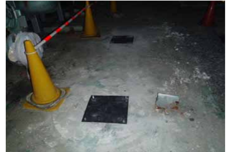
グラウト充填部完了(閉止板設置) 写真
