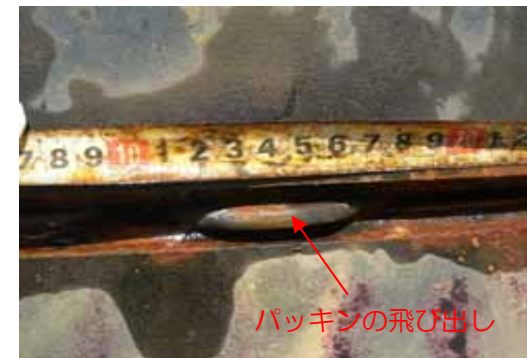
解体前のリークパス部底板裏面
