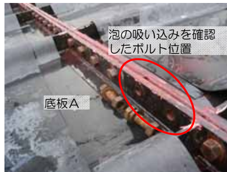
底板内面フランジ部PT塗布状況
