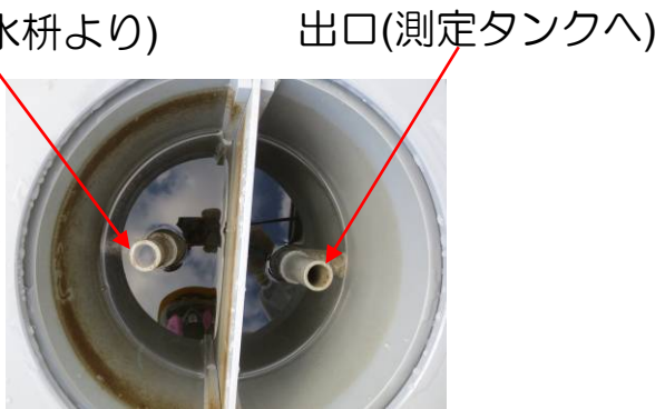
沈降槽内部状況
