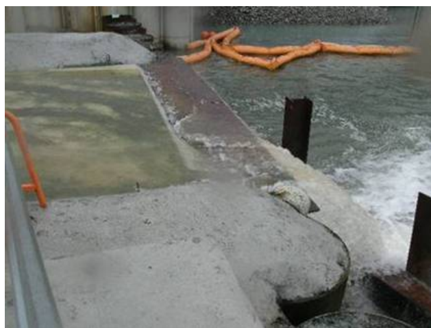
仮排水口からの排水の様子（STEP2）
