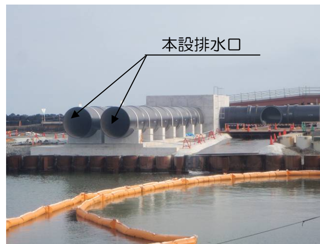
本設排水口状況
