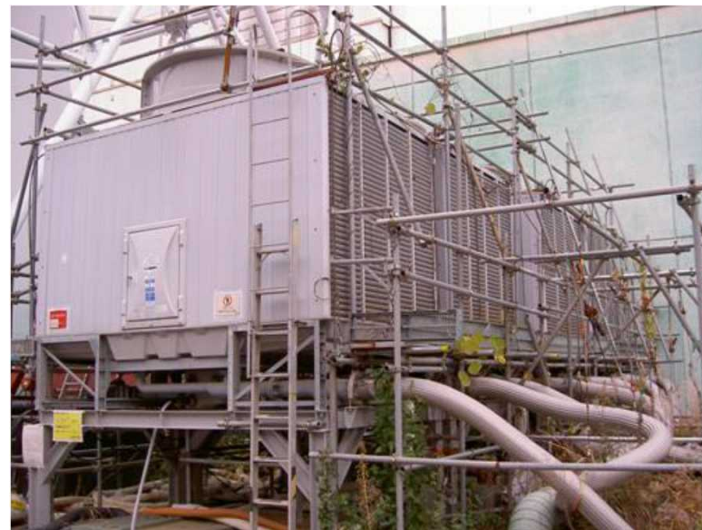
【昨年度例：SFP冷却設備2号冷却塔】
