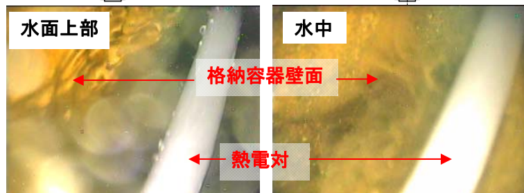
図1：2号機原子炉格納容器内部調査結果
