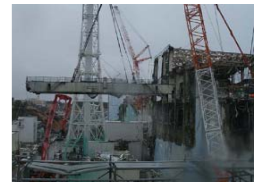
4号機原子炉建屋 天井クレーンガーター撤去作業
