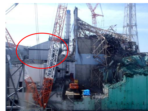
3号機原子炉建屋 上部瓦礫撤去用構台設置〔東側〕
