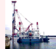
遮水壁先行削孔 作業状況
