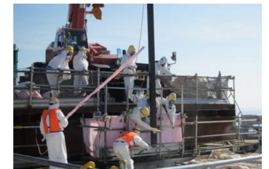
図5：4号機使用済燃料プール新燃料取出し作業
