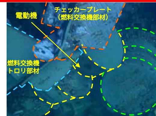
画像①：燃料交換機の電動機
