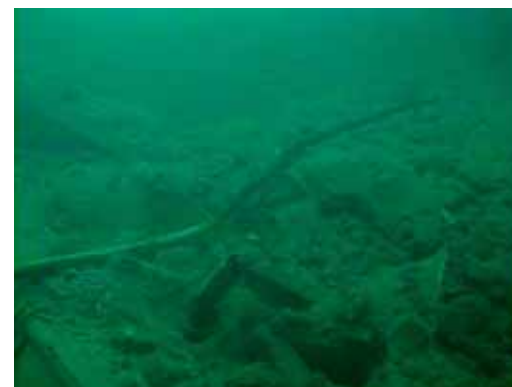
画像④：使用済燃料ラック上部の堆積物
