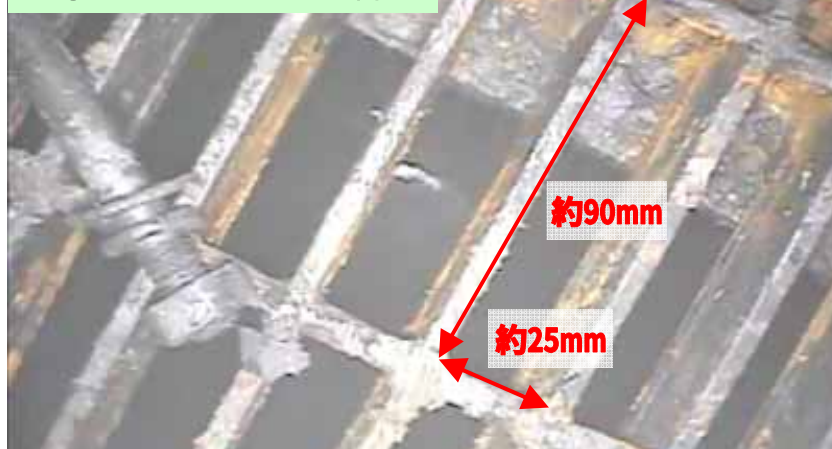
⑤ グレーチング上部
