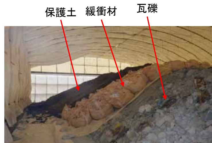
1槽目内部の状態(11/1)
