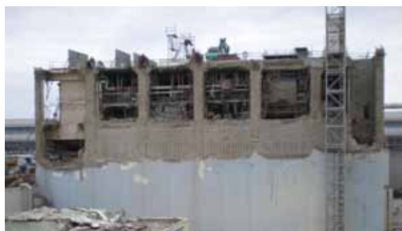
⑤ 西面（外壁）
