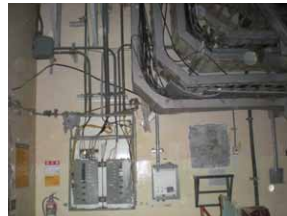
④ 西面（内壁）
