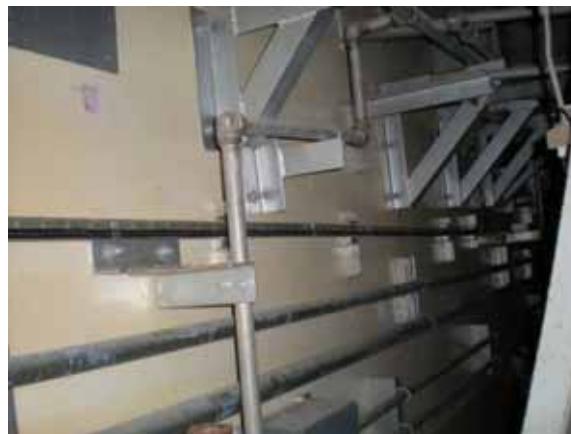
③ 使用済燃料 プール側壁面
