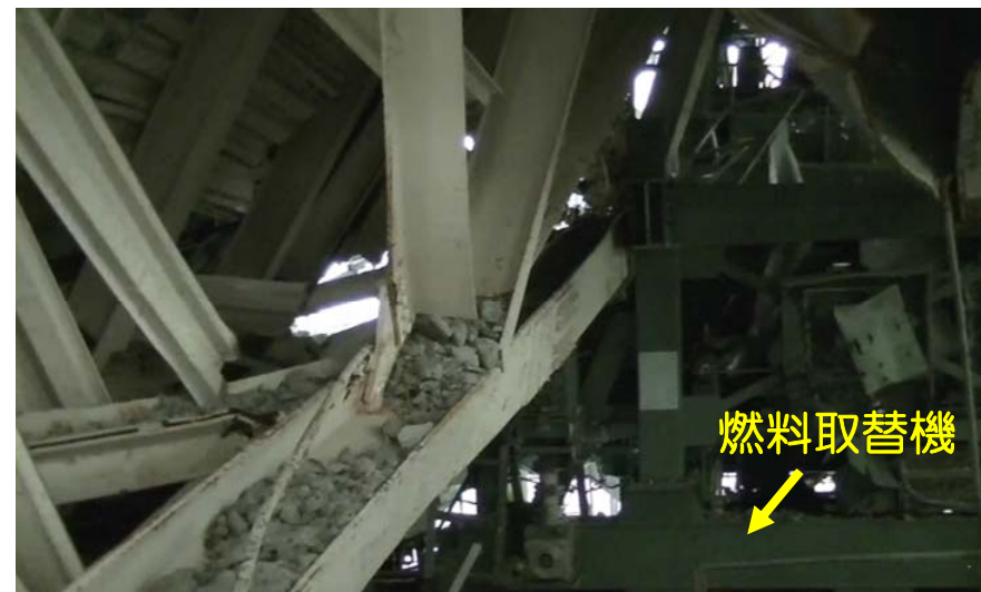
バルーンからみた北東方向の写真
