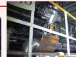
格納容器側状況
