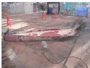
撤去後の様子
