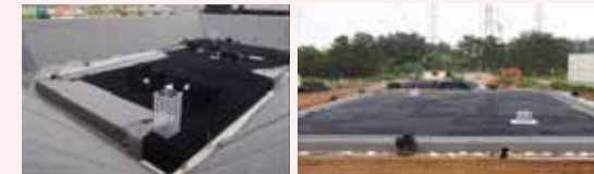
地下貯水槽設置状況
