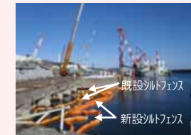
シルトフェンス交換の様子
