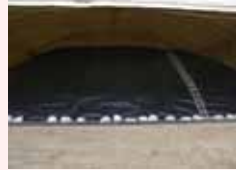
1槽目の様子（12/13） 遮水シート設置中
