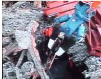
吊り上げ時の様子
