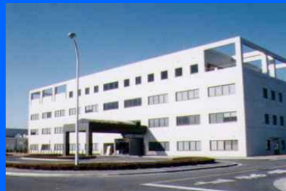
地層処分基盤研究施設
