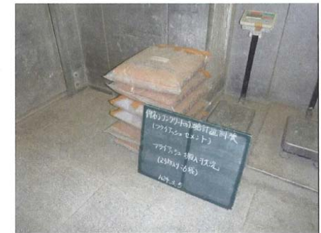
状況写真2 材料搬入状況(フライアッシュ)
