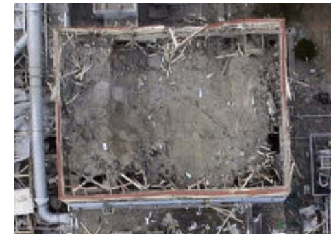
1号屋上階（カバー設置前）
