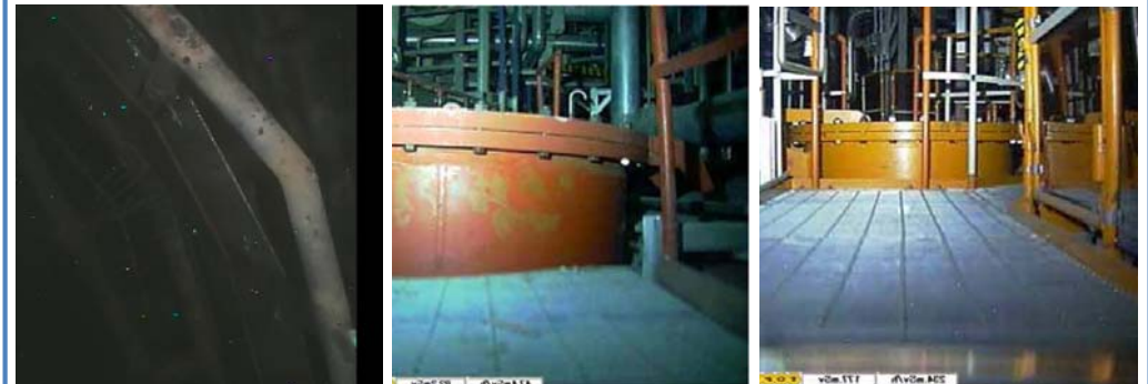
1号機トラス室内部
