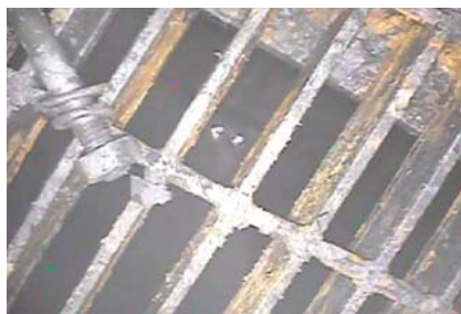
1号機PCV内部(水面確認)
