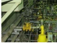
狭隘な場所での解体作業
