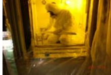
核燃料物質等で汚染された場所での解体作業
