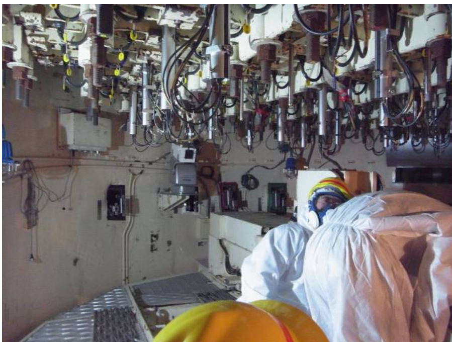
格納容器内部 (原子炉圧力容器底部を下から見上げる位置)
