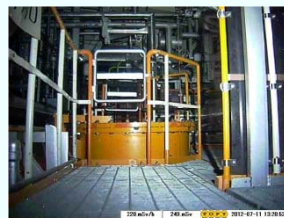
トラス室内の様子
