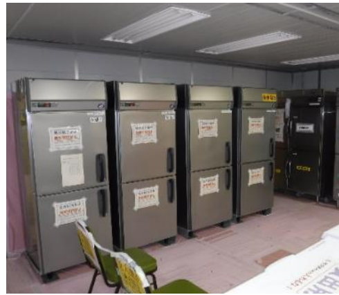
保冷剤冷凍庫の配備
