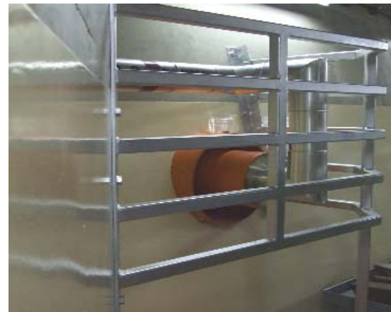
配管保護柵の設置
