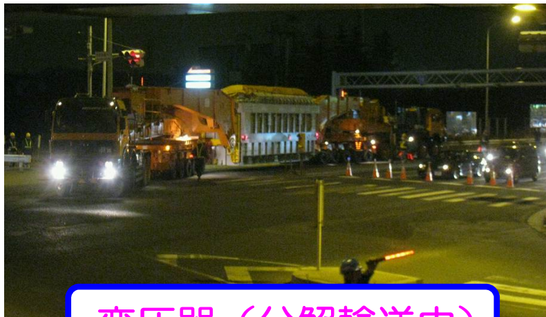
変圧器（分解輸送中）
