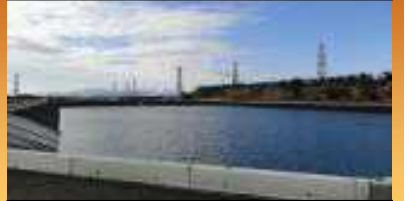
淡水貯水池設置
