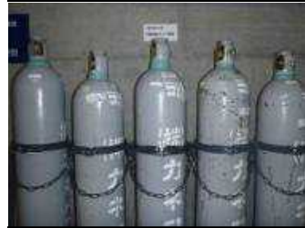
予備ポンベの配備
