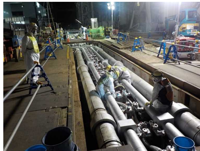
冷媒の移送管
