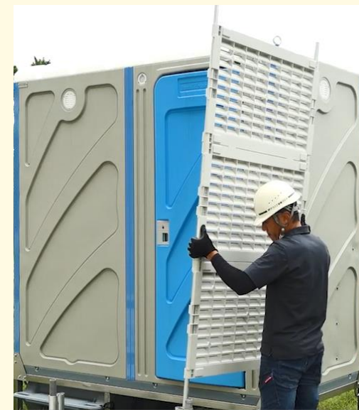
仮設トイレ設置の様子
