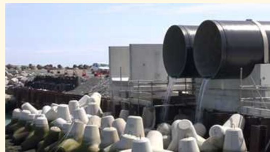
港湾内へ付け替えたK排水路の排出口
