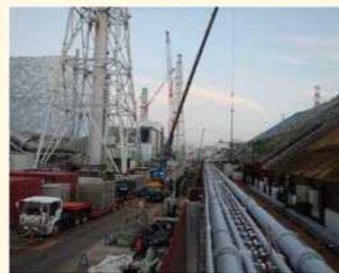
2～4号機西側に敷設した凍結管
