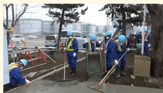
汚染状態に応じた装備区分の変更 (構内専用服での作業)
