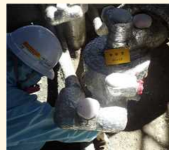
陸側遮水壁の凍結開始
