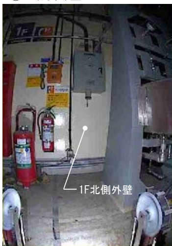
①1F北側外壁
