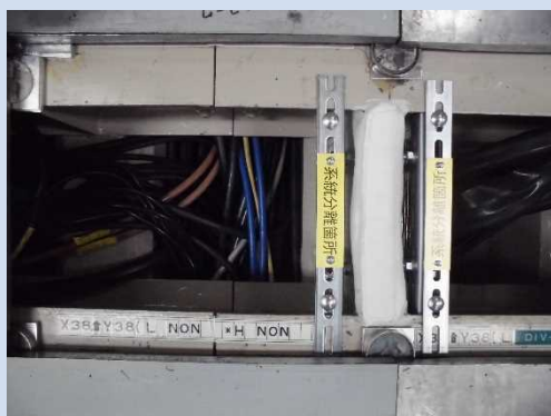
跨ぎ解消状況
