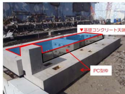
瓦礫撤去用構台東側基礎部 PC型枠設置
