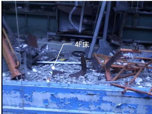
⑥4F床 (大物搬入口北側)
