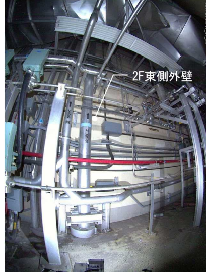
④2F東側外壁
