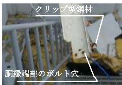
(B) 胴縁端部のボルト穴
