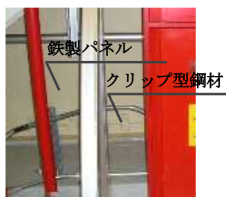
(A) 鉄製パネルと胴縁の接続
