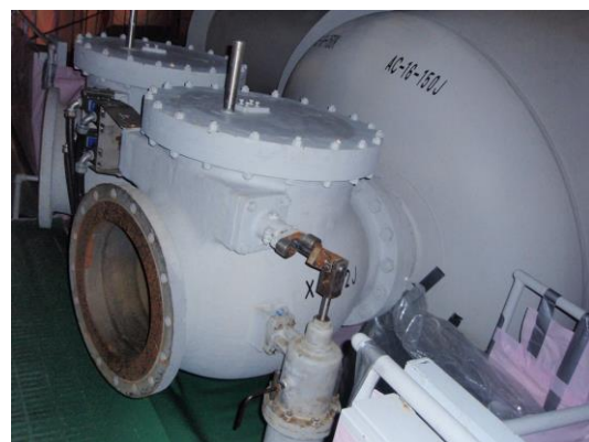
図 2 真空破壊弁
